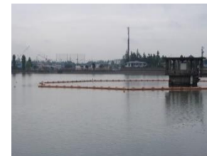
横浜水道相模原沈殿池
